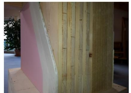
**3.4 „NUR-HOLZ“ Außenwand, ca.  $U = 0,19 \text{ W/m}^2\text{K}$  (auf Wunsch verbesserte Werte),  $R_w 48 \text{ db}$ , Phasenverschiebung 22,3 h, Wandstärke 34,57 cm, Wandaufbau von innen nach außen:**
